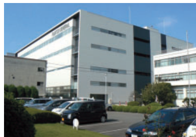
完成した空調技術棟
