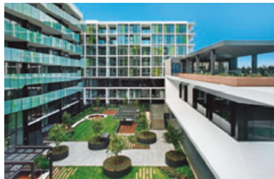
当社製VRFが納入されているオーストラリアメルボルンのマンション
