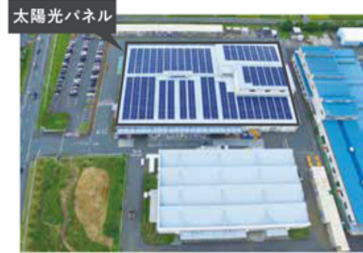
浜松事業所にて屋上に太陽光パネル設置
